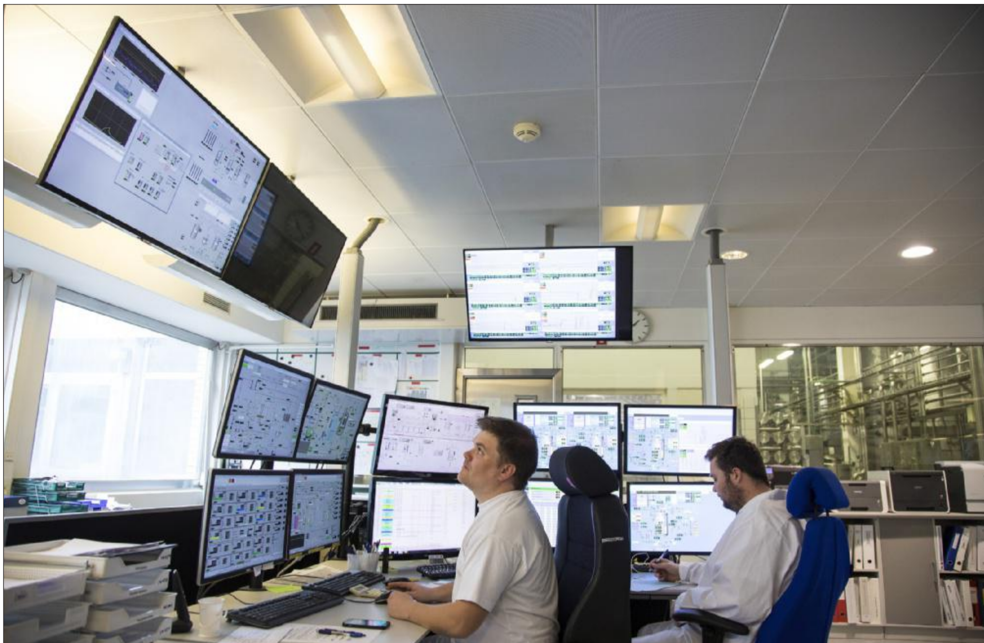
I operatørrummet kan operatørerne René Kaagh og Lasse Brodersen holde øje med produktionsflowet på et væld af computerskærme. Foto: Anders Bach
